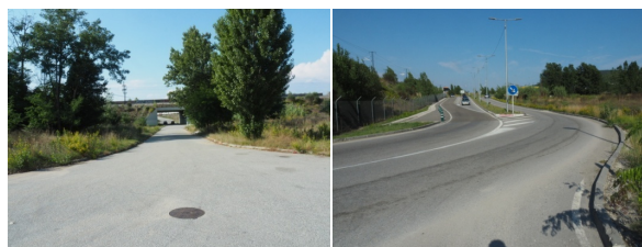
F24. Vista accés sota del TAV a la part nord-oest i vial 6 accés BV 5105
