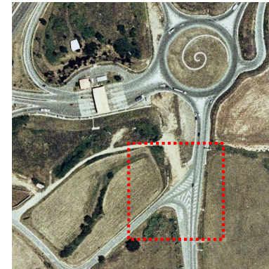
Ortofoto ICGC any 2004: Execució de les obres recollides en el Projecte Modificat de la Variant de Cardedeu i Llinars del Vallès C-35, tram carretera BV-5105 PK 2+690 a carretera C-251 PK 15+480 (Clau VB-97015-M1). Detall accés Sector de Can Massaguer per Vial 6.
