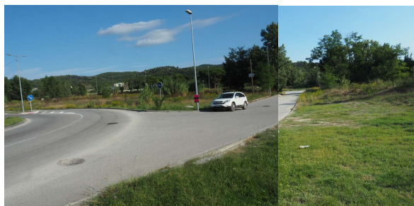
F23. Vial 6 i accés sistemes espais lliures i equipaments a la part sud-est
