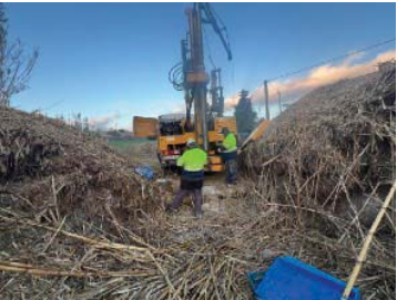
Fot. 1. Màquina de sondejos RL400 posicionada en el punt de reconeixement 1908S1.
