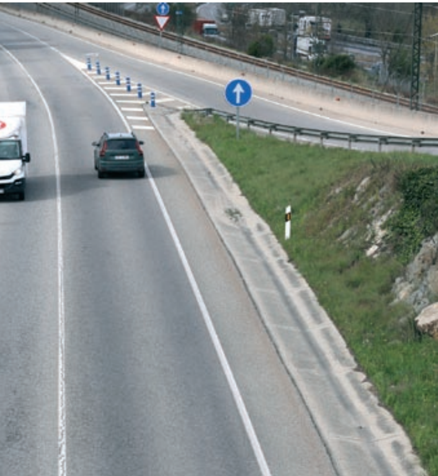
un tercer carril i separarà els sentits de circulació amb una mitjana de formigó
