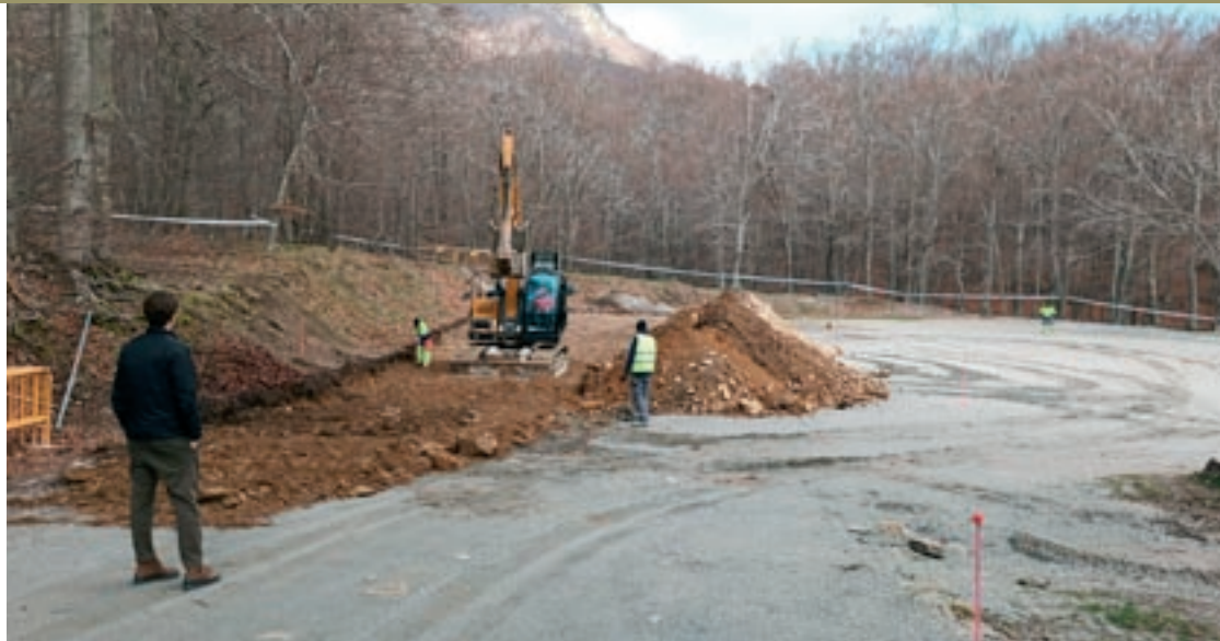
Treballs en marxa aquesta setmana a l'aparcament de Can Casades, al peu de la BV-5114
