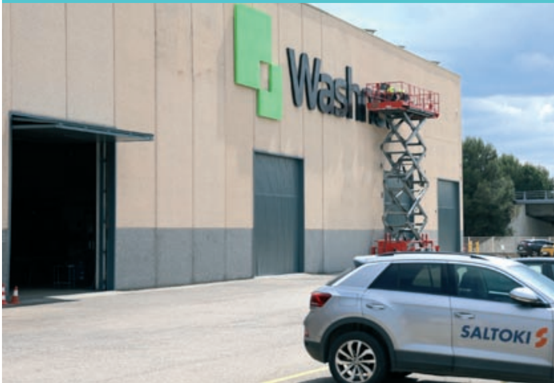
Uns operaris acaben d'instal·lar els rètols amb la nova imatge de Washnet a la planta de les Franqueses
