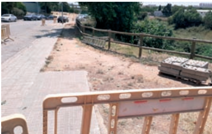
Les obres al passeig de mossèn Cinto Verdaguer
