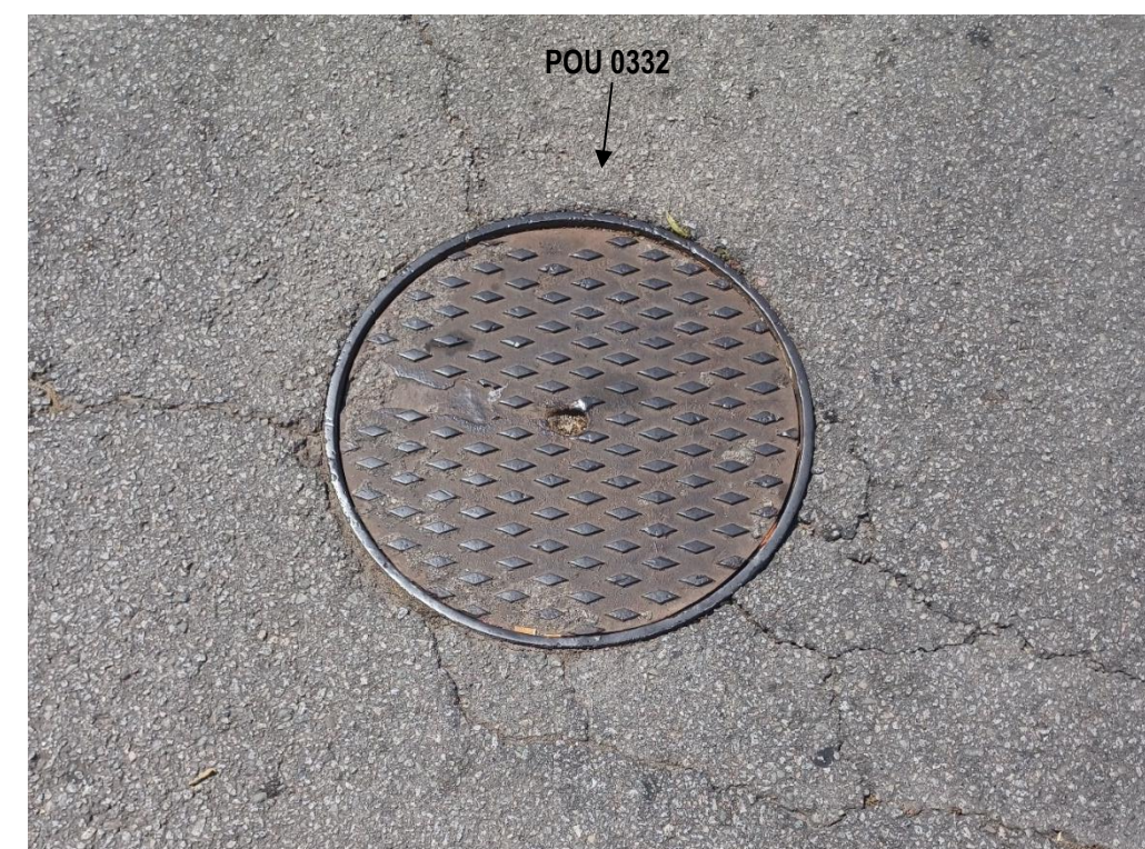
Fotografia 3: Carrer Font del Cargol, Pou 0332
