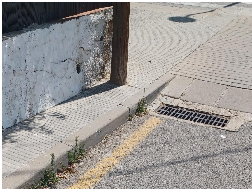
Fotografia 5: Passatge Espanya, vista de l'últim tram de la vorera
