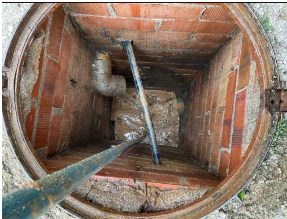
Imatge. 1. Estat del pou 227 durant els treballs d'inspecció
