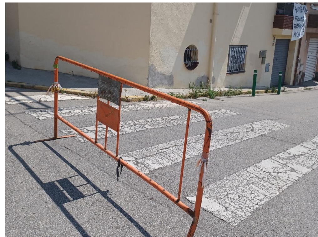
Fotografia 6: Inici del tram de Passatge Espanya on treballar i exemple de tall del trànsit
